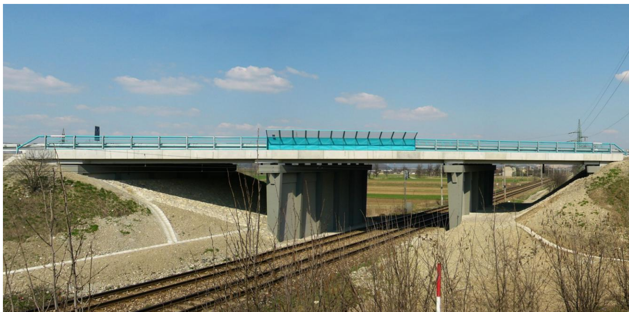
Obr. 10 Pohľad na most pred dokončením
