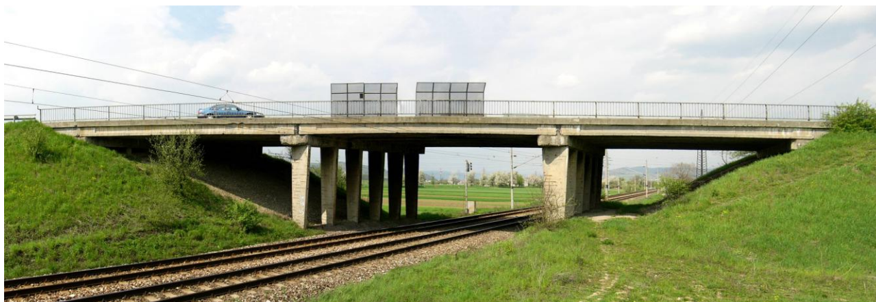
Obr. 1 Pohľad na pôvodný most
